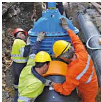
Interventi sulla rete gas e una cabina di ricezione del metano
