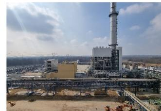
**N. 2 caldaie ausiliarie (9,3 MWt cadauna)** alimentate a gas naturale per la produzione di vapore ausiliario per le unità termoelettriche in ciclo combinato TL800 e TL400 e per altri servizi della Centrale.
