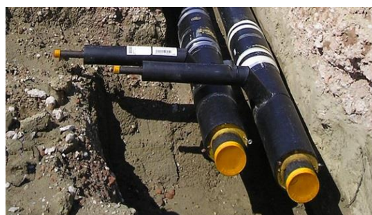
Tubazioni preisolate di teleriscaldamento.
