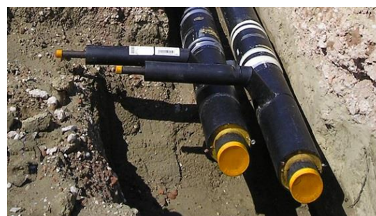
Tubazioni di teleriscaldamento preisolate.
