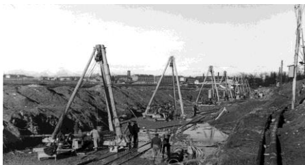
La diga del Pascolo in costruzione - anni '50
