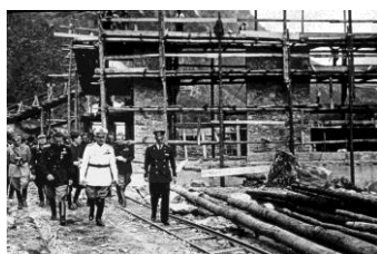
Costruzione Centrale Pont - 1942
