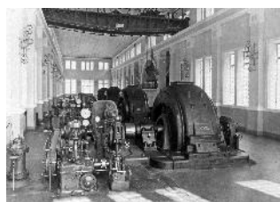
Sala macchine Centrale Rosone - 1930
