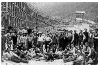
Costruzione diga di Ceresole - 1928
