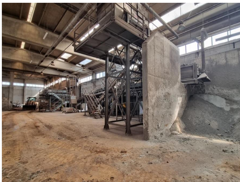
Figura 7 – Vista dell'impianto di trattamento dei rifiuti solidi
