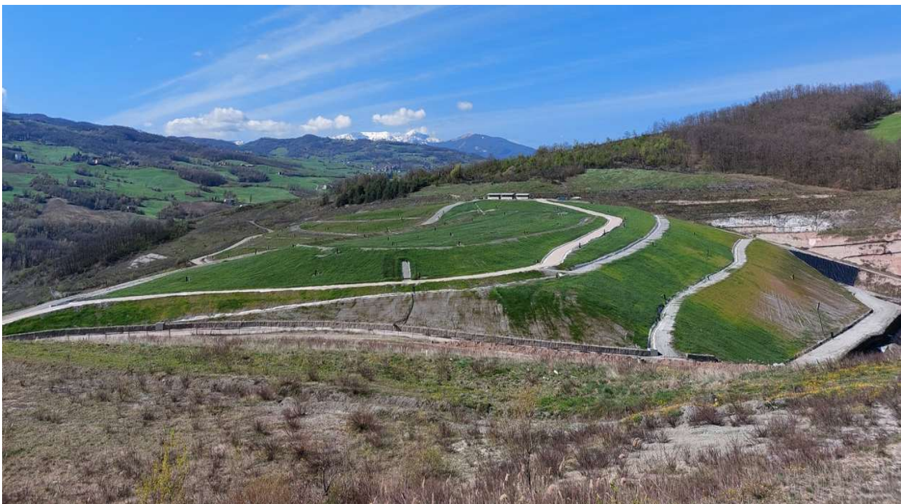
Fig 3. Panoramica discarica con dettaglio copertura definitiva
