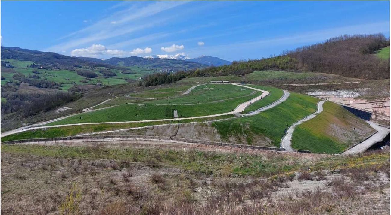
Fig 3. Panoramica discarica con dettaglio copertura definitiva
