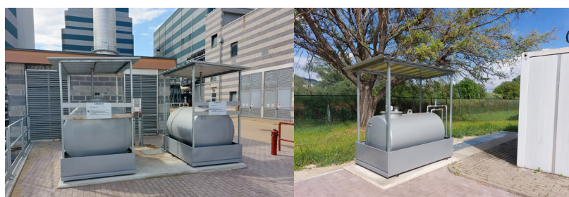
Foto obiettivo 8: installazione n. 3 serbatoi gasolio fuori terra al posto di serbatoi interrati
